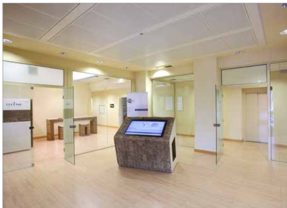
Realizzazione con soffitti radianti metallici
